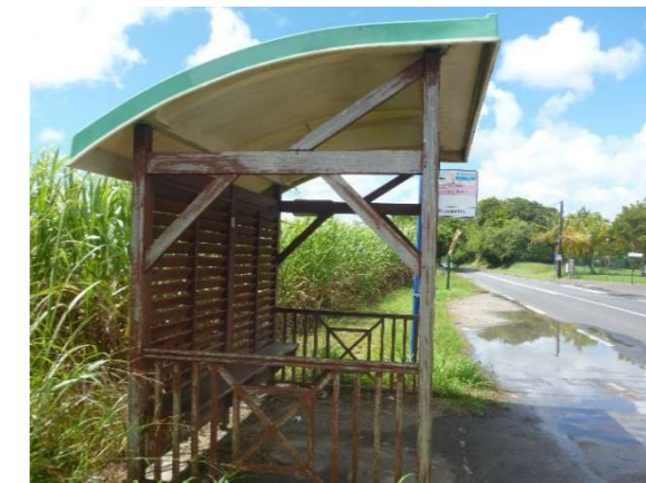
Figure 18 : Arrêt de bus sur la RN5, à l'Est de la zone du projet, en face de la caserne des pompiers
