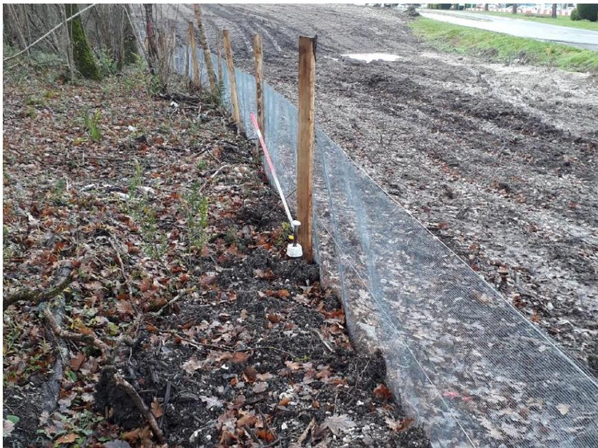
*Figure 4 exemple de clôture à mailles fines réduisant le risque de retour des reptiles et amphibiens (sommet à incliner vers l'extérieur du site), à implanter à la fin des opérations de débroussaillage / déboisement.*
